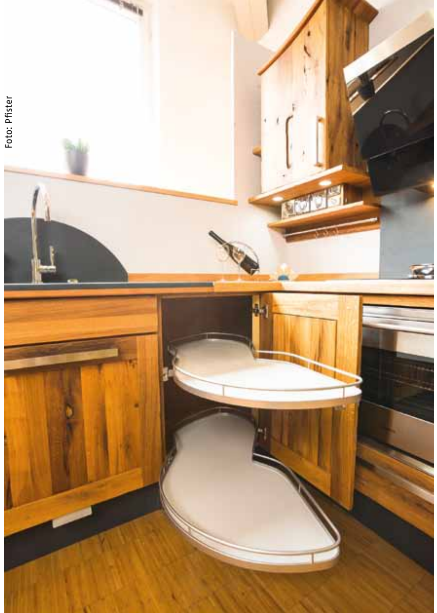
Hinter den betagten Fronten kommt aktuelle Technik zum Einsatz.
